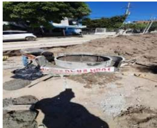
Construcción pozo de inspección en concreto reforzado e impermeabilizado para tuberías de diámetro entre 18" y 33".
