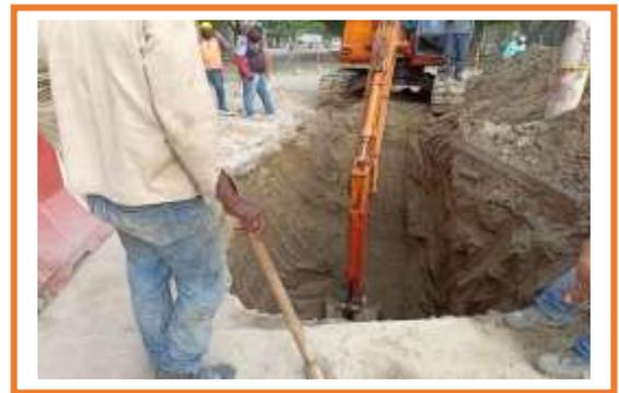
Fuente: Setp Santa Marta. Empalme del colector de alcantarillado sanitario proyectado al colector existente.
