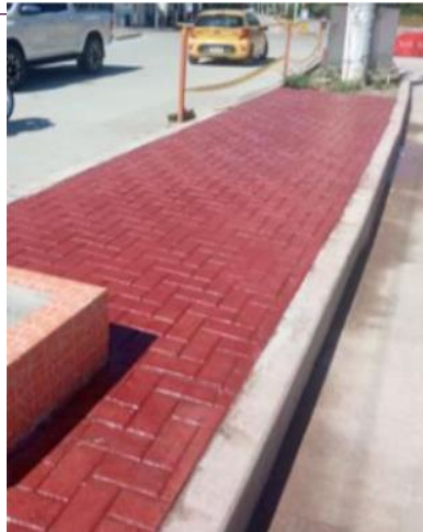
Ilustración 4. Concreto estampado separador central.
