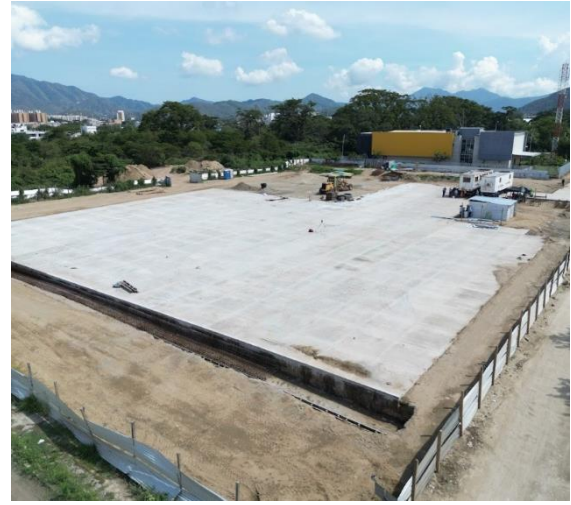
Ilustración 13. Vista en terreno. Pavimento rígido vehicular instalado.
