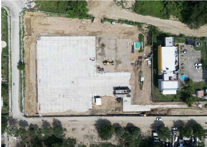
Ilustración 12. Vista área construcción del Patio Taller Libano.
