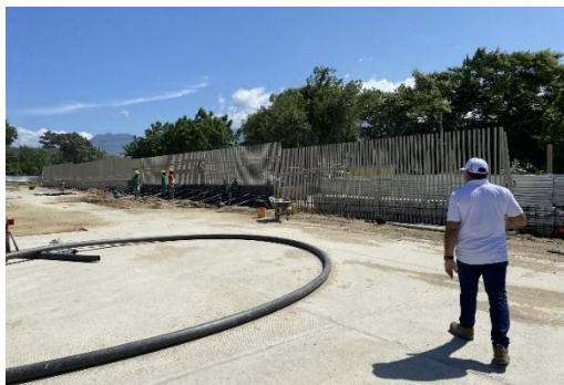
Ilustración 14. Construcción del cerramiento perimetral tubular.
