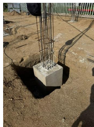
Ilustración 17. Cimentación edificio administrativo .
