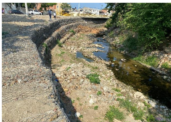
Ilustración 8. Obras de protección río Manzanares.
