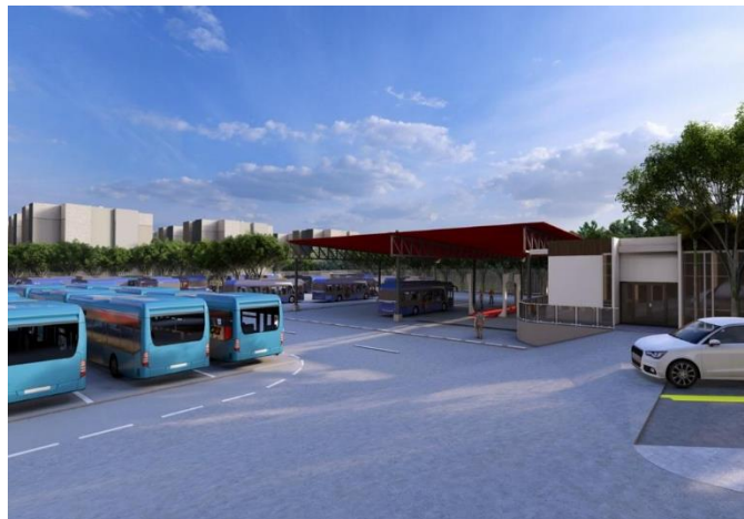
Ilustración 11. Imagen realista a partir del diseño arquitectónico (render) del Patio Taller Líbano.
