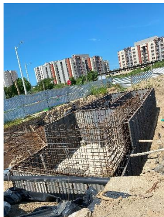
Ilustración 16. Construcción de los tanques subterráneos.
